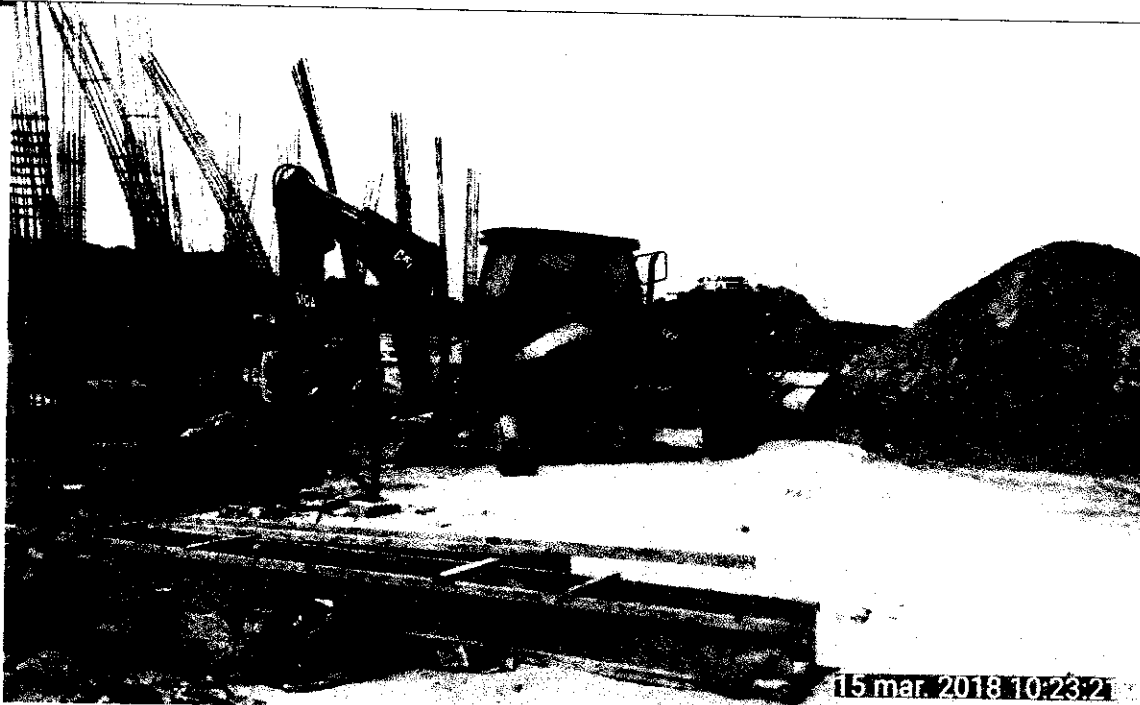
Imagen N°5: A la vista de la imagen se aprecia a la retroexcavadora haciendo trabajos de excavación con el apoyo de un vigía para reducir riesgos dentro de la obra.
