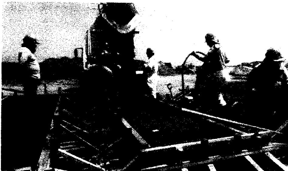
Concreto f'c 280 kg/cm 2 c/impermeabilizante (05.05.01)
