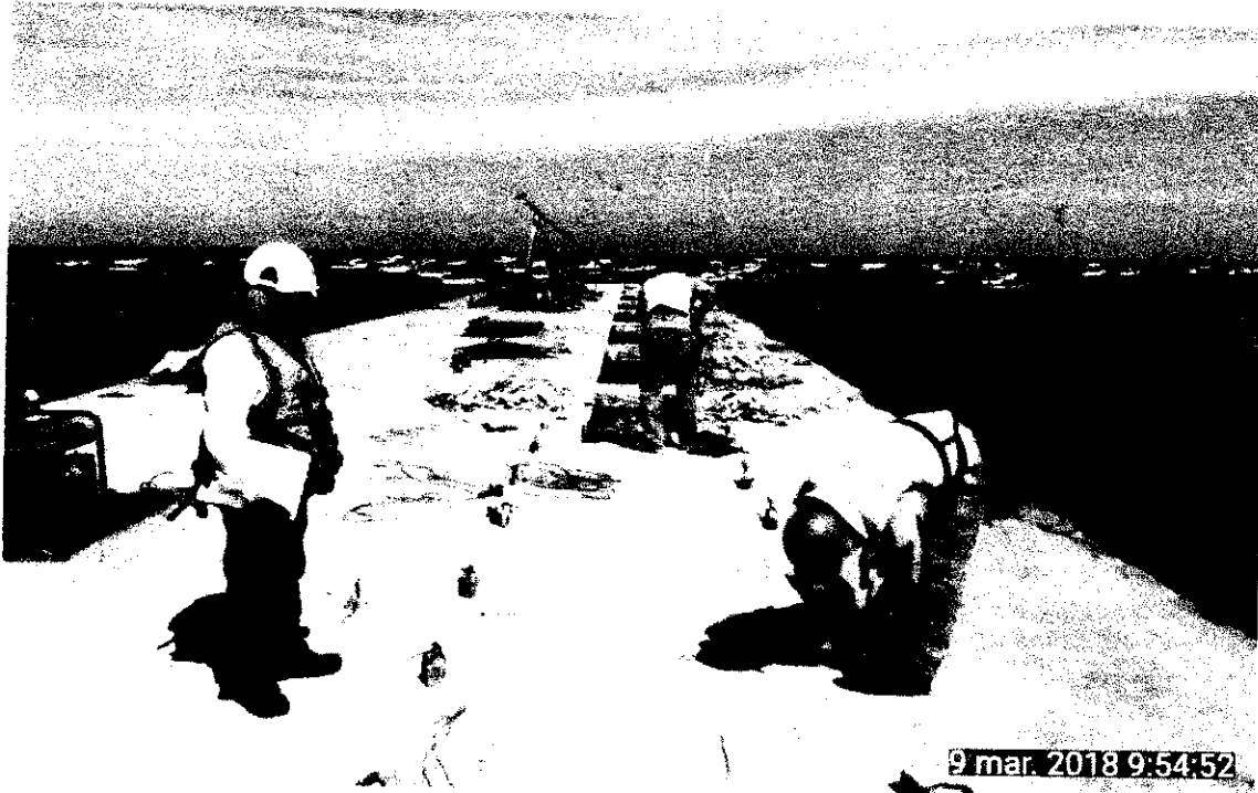
Imagen N°1: A la vista de la imagen se aprecia a los trabajadores realizando trabajos de demolición en la loza del muelle cumpliendo con las normas de seguridad, EPP's, ( así como chalecos de salvataje, aros de salvavidas, chaleco herramientas señalizadas.
